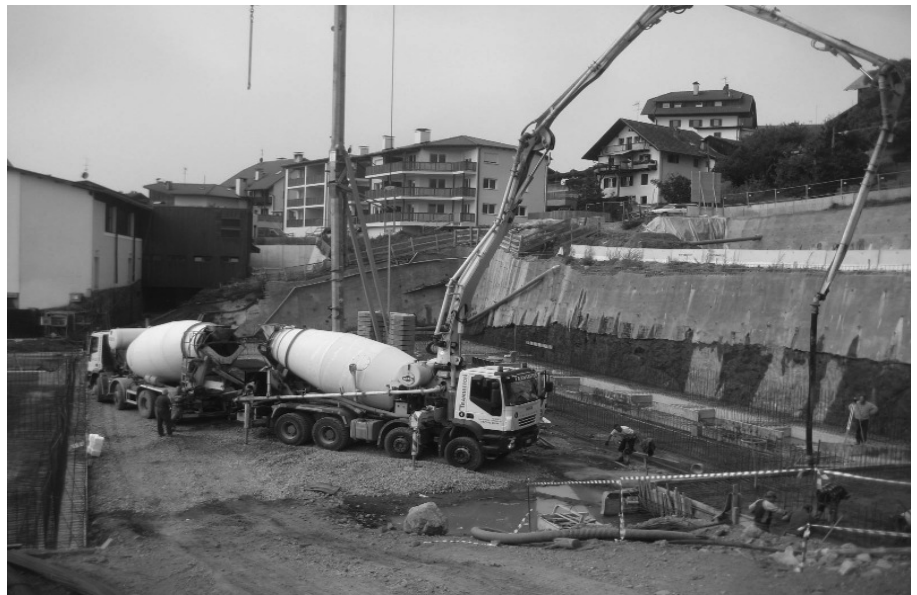
Der Bau der Turnhalle schreitet nach anfänglichen Startschwierigkeiten nun zügig voran.
