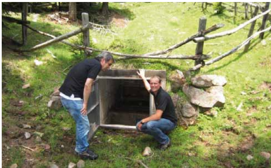
Bürgermeister Paul Romen und Wasserreferent Daniel Untertrifaller haben im Sommer gemeinsam mit Wasserwart Klemens Pircher alle Quelfassungen und Wasserspeicher auf Gemeindegebiet esichtigt und geprüft um einen detaillierten Überblick über den Zustand der Wasserversorgung im Gemeindegebiet zu erhalten.
